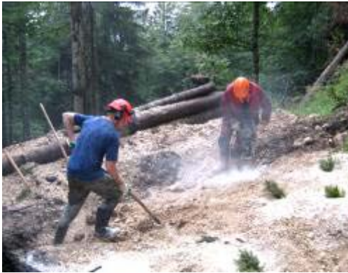
Sepp und Christian Hutterer beim Bohren der Sprenglöcher. Foto: D. Kuffner
